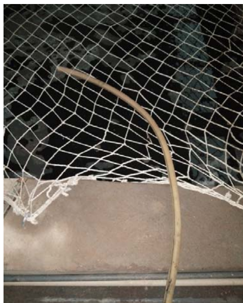
图 4.1.1-4 废水处理站喷雾管
