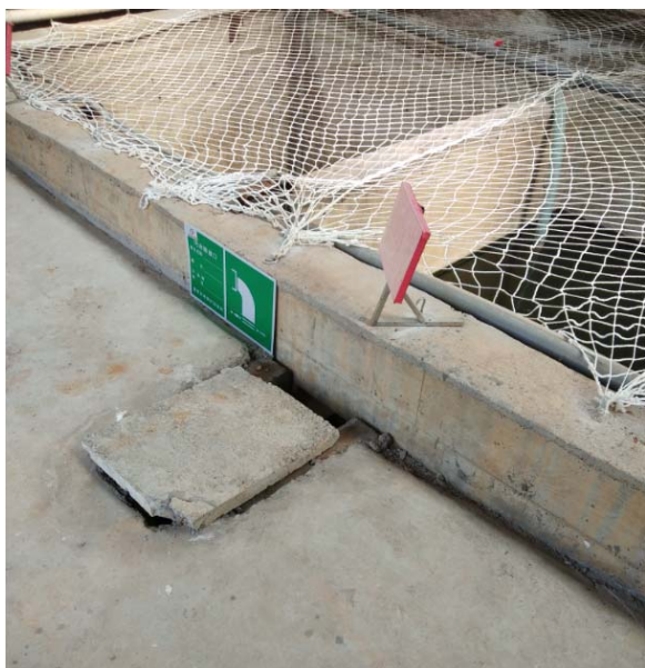
图 4.1.1-3 废水处理站排放口
