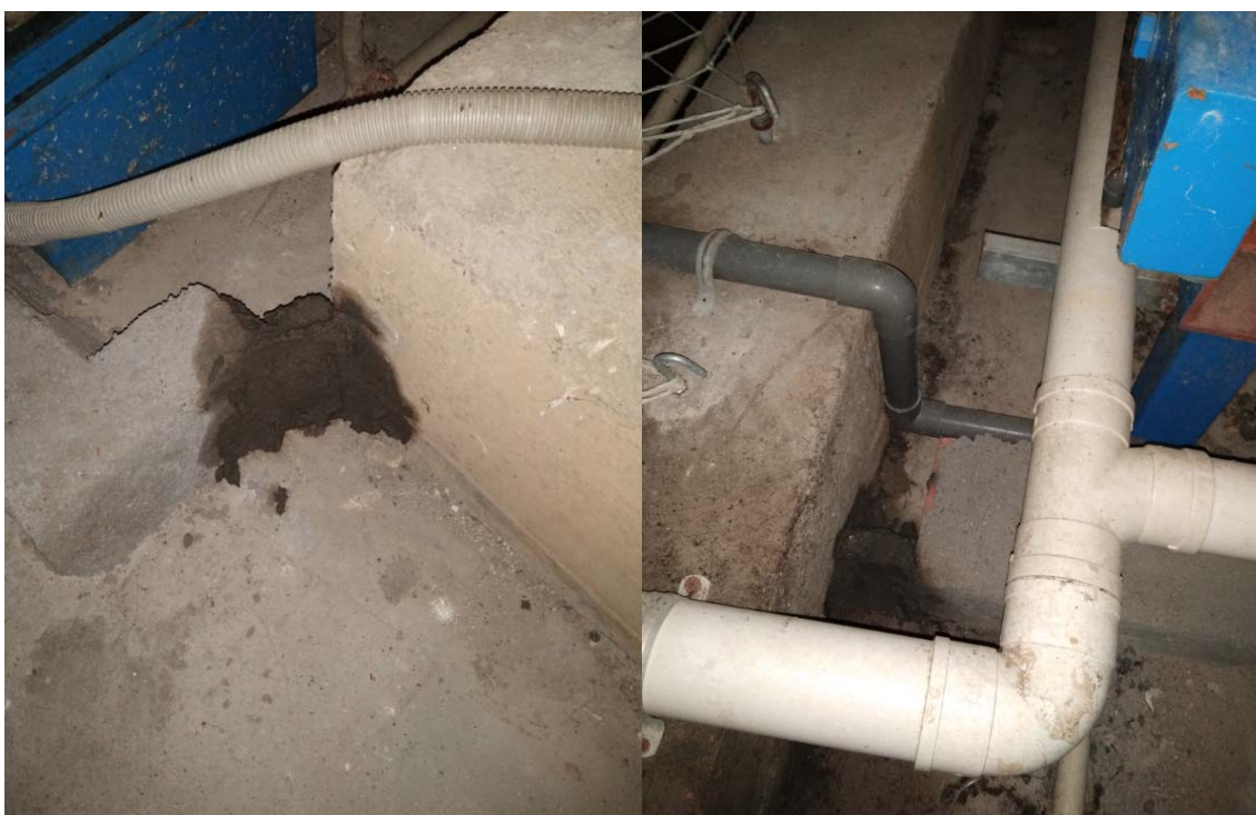
图 10.4-2 完善污泥脱水区域围堰
